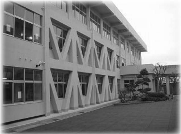
M型に見える鉄骨プレス工法により耐震補強がなされています。
